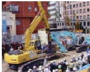
電動化掘削機械(左:テレスコ、右:バックホウ)
