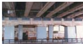
高架橋橋脚耐震補強と落橋防止
