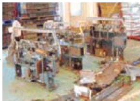
自動改札機 解体中
