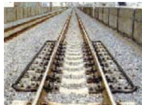
ロングレール
