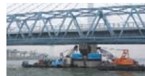
荒川・中川橋梁橋脚の補強工事
