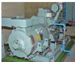
非常用発電機
