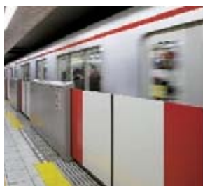
丸ノ内線の可動式ホーム柵
