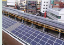
屋根上の太陽光発電パネル
