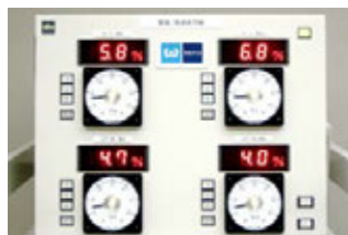
総合指令所内の風速監視装置
