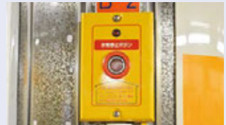
非常停止ボタン
