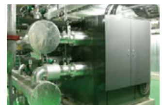
チラー(冷凍機)
