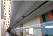
LEDを用いた駅構内照明
