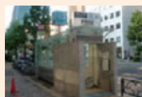
完全防水型出入口
