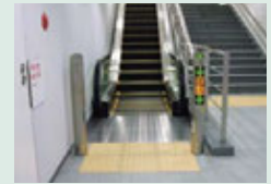
自動運転装置付エスカレーター
