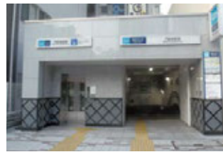
バリアフリー化された出入口
