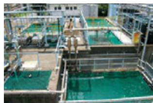
排水除害設備
