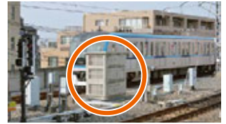
駅補助電源装置
