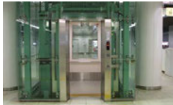
エレベーター
