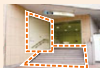
嵩上げた駅出入口と防水扉
