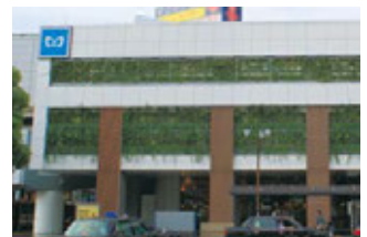
壁面緑化された浦安駅
