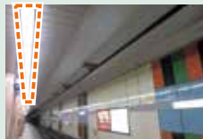
LEDを用いた駅構内照明
