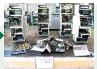
自動券売機 解体中
