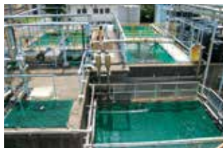
排水除害設備
