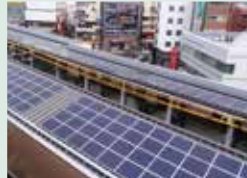
屋根上の太陽光発電パネル
