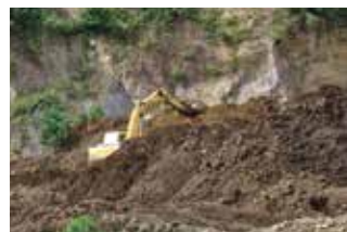
建設発生土の再利用(採石場跡への埋立て)
