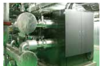
チラー(冷凍機)
