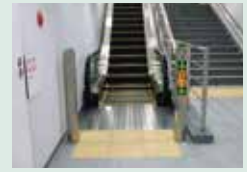
自動運転装置付エスカレーター
