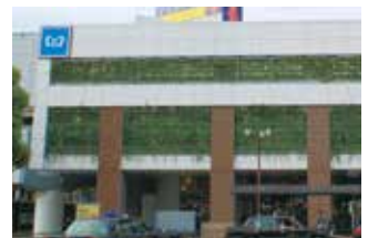
壁面緑化された浦安駅
