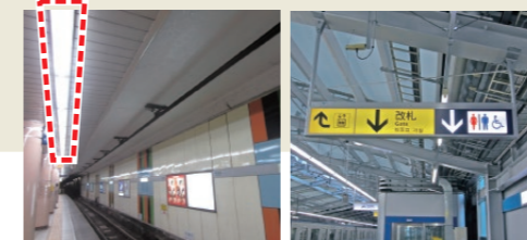
LEDを用いた駅構内照明
