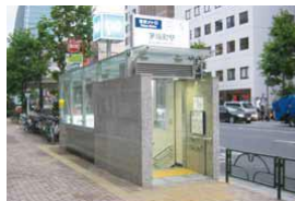
完全防水型出入口(茅場町駅)
