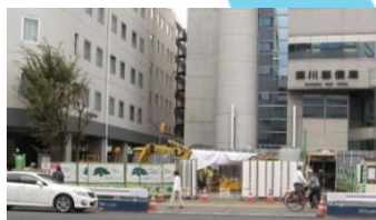
東陽町駅出入口予定地
