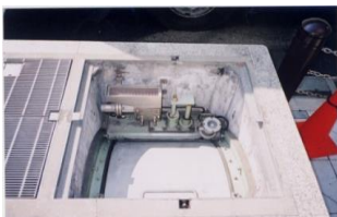
換気口浸水防止機
