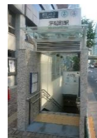
完全防水型出入口（左：通常時、右：閉扉時）
