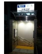
完全防水型出入口（左：通常時、右：閉扉時）
