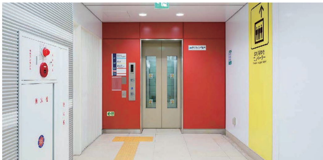
エレベーター1ルート整備
