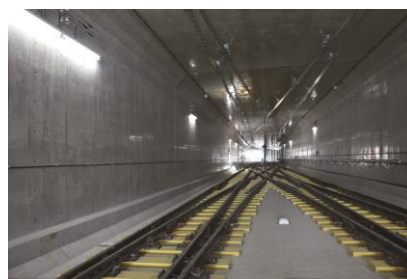
模擬トンネル
