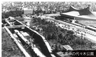
工事中の代々木公園
