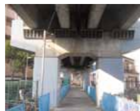
高架橋耐震補強(落橋防止、柱補強)
