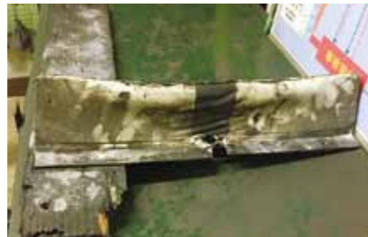
溶損した保守用車用一旦停止標
