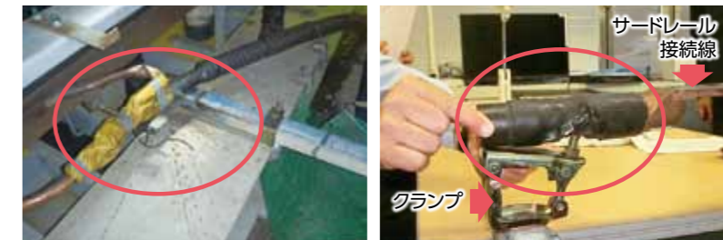
地絡発生箇所
