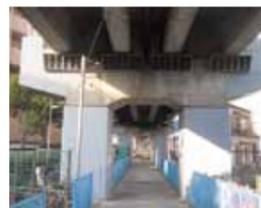
高架橋耐震補強(落橋防止、柱補強)
