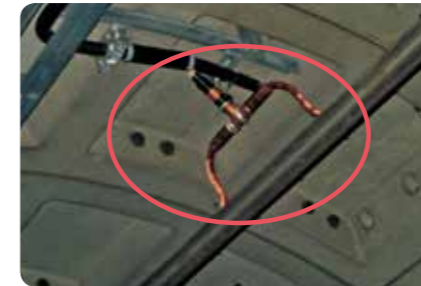
T分岐仮止めの状態
