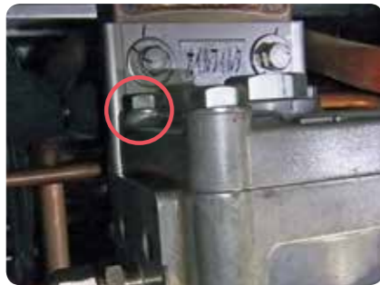
オイルフィルタボルト緩み箇所
