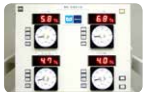
総合指令所内の風速監視装置
