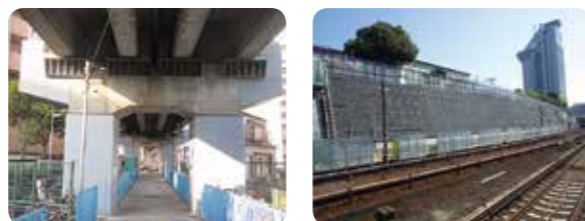
高架橋耐震補強 (落橋防止、柱補強)
