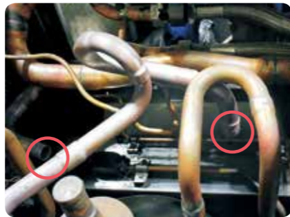
ろう付け箇所から外れた配管
