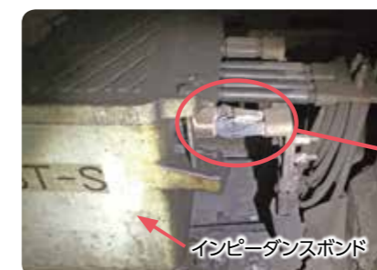
インピーダンスボンド損傷
