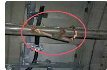
T分岐事故発生時
