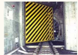
トンネル防水ゲート
