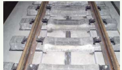
防振まくらぎ軌道
