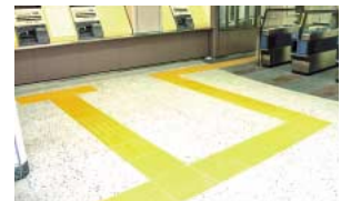
点字ブロック
