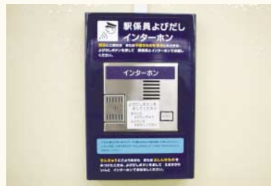
駅係員呼出しインターホン
