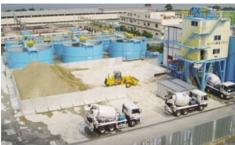
建設汚泥リサイクル施設
