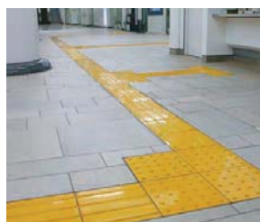
点状・線状ブロック
