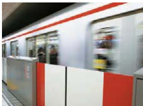
丸ノ内線の可動式ホーム柵
