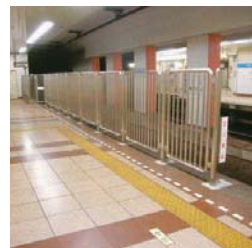
転落防止の固定柵
