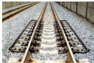
ロングレール
