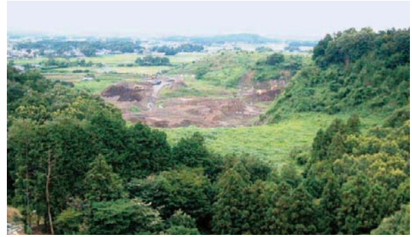
発生土の再利用(採石場跡の埋め立て)
