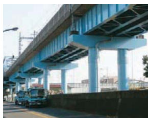
新砂町高架橋
