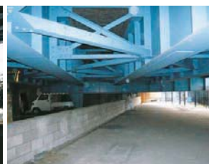
蛇崩川橋りょう
