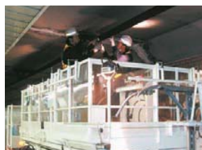
トンネル内作業
