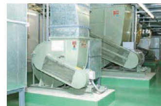
排煙設備(排煙機)
