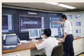
駅の防災管理施設
