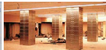
店舗部高架橋橋脚耐震補強
