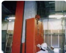
高架橋柱の耐震補強工事の様子
