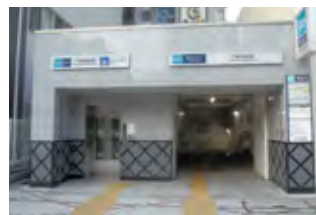
バリアフリー化された出入口
