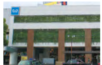
壁面緑化された浦安駅
