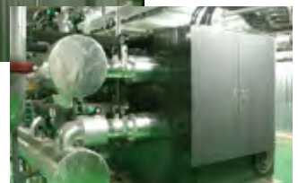
チラー(冷凍機)
