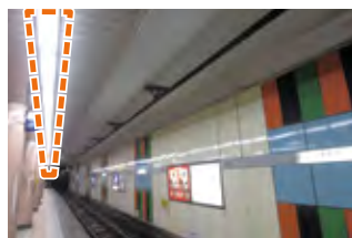
LEDを用いた駅構内照明
