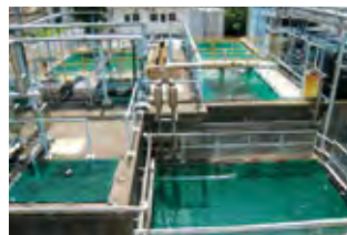
排水除害設備
