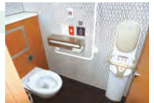
節水栓を設置した麹町駅のトイレ
