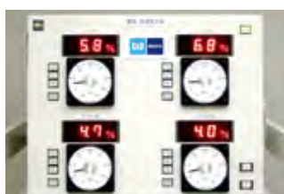
総合指令所内の風速監視装置
