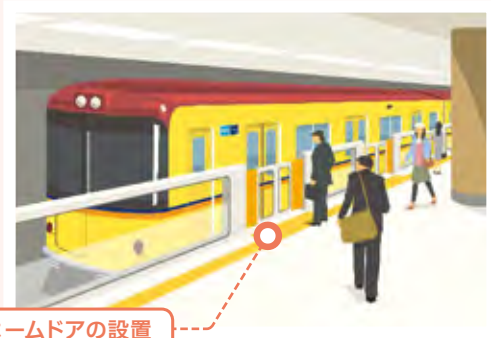
ホームドアの設置
