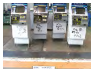
自動券売機 解体前
