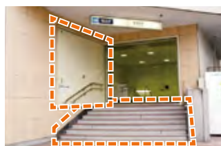
かさ上げした駅出入口と防水扉
