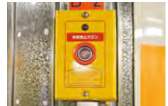
非常停止ボタン
