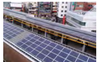
屋根上の太陽光発電パネル
