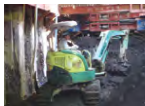
建設発生土の再利用(採石場跡への埋立て)
