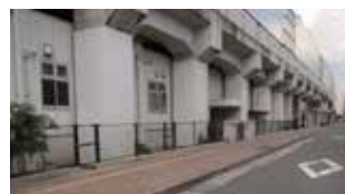
高架橋柱補強
