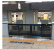
東西線九段下駅 大開口ホームドア
