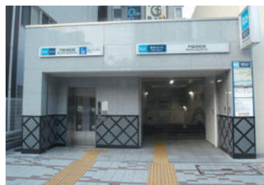
バリアフリー化された出入口
