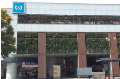
壁面緑化された浦安駅
