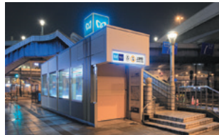
大規模浸水対策後 (完全防水型出入口設置)
