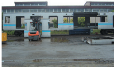
内装を撤去した車内
