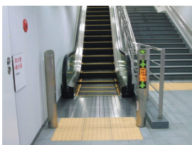
自動運転装置付エスカレーター
