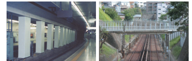
トンネル中柱 こ線橋(補強前)
