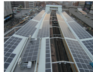
屋根上の太陽光発電パネル
