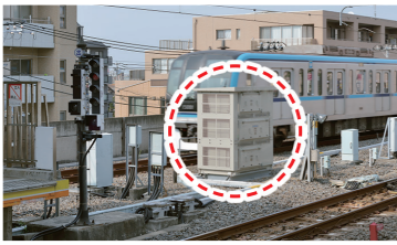
駅補助電源装置
