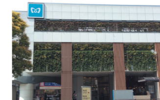
壁面緑化された浦安駅
