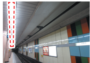
LEDを用いた駅構内照明
