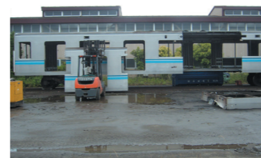
内装を撤去した車内
