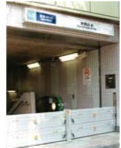
駅出入口に設置した止水板
