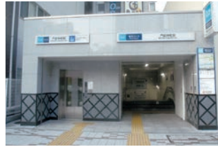
バリアフリー化された出入口
