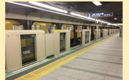
ホームドア設置後のホームの状況(浅草駅)
