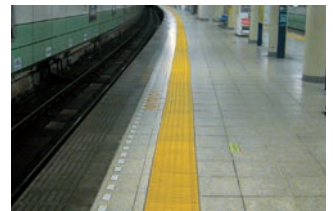
ホーム縁端警告ブロック
