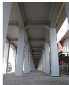
高架橋柱耐震補強
