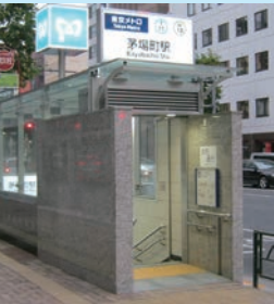
大規模浸水対策後 (完全防水型出入口設置)
