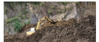
建設発生土の再利用(採石場跡への埋立て)
