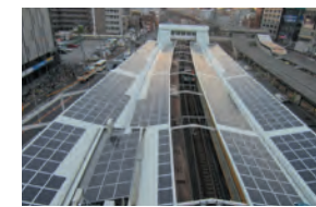
太陽光発電システム
