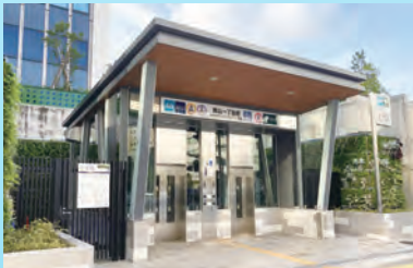
エレベーターの整備(青山一丁目駅)
