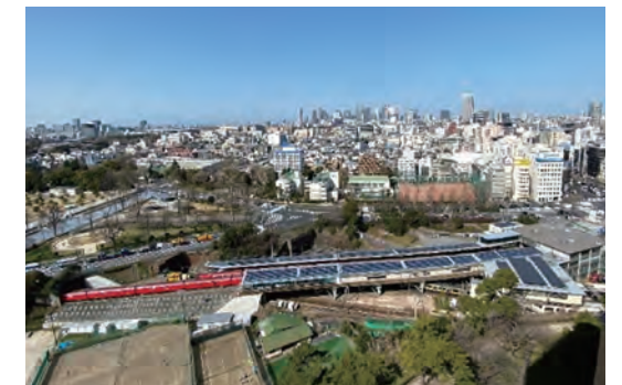
丸ノ内線四ツ谷駅の太陽光パネル
