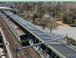
千代田線北綾瀬駅太陽光発電システム
