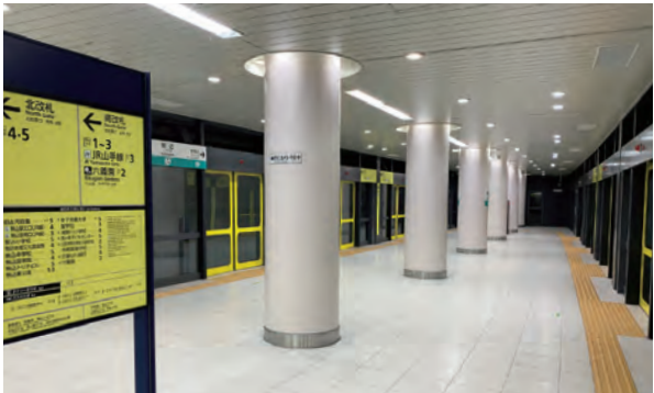
駒込駅ホーム延伸部
