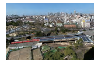
太陽光発電システム
