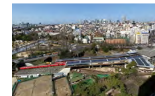
太陽光発電システム
