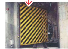
トンネルの断面を閉鎖することができる防水ゲートを設置。
