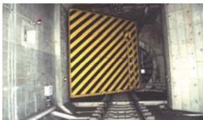
トンネルの断面を閉鎖することができる防水ゲートを設置します。
