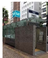
完全防水型出入口 (茅場町駅)
