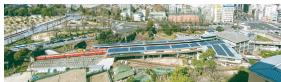
太陽光発電システム
