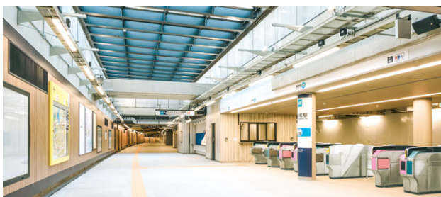
南砂町駅改良工事後
