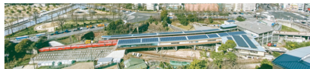
太陽光発電システム
