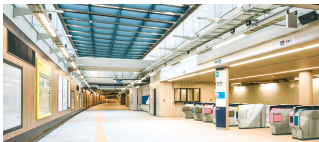
南砂町駅改良工事後
