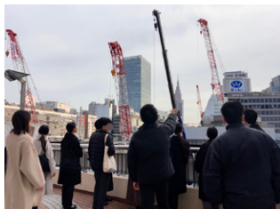
総合職事務系の仕事体験で新宿駅西口地区再開発工事を見学する様子
