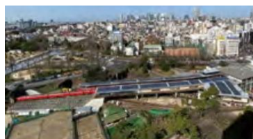
▲丸ノ内線四ツ谷駅の太陽光パネル
