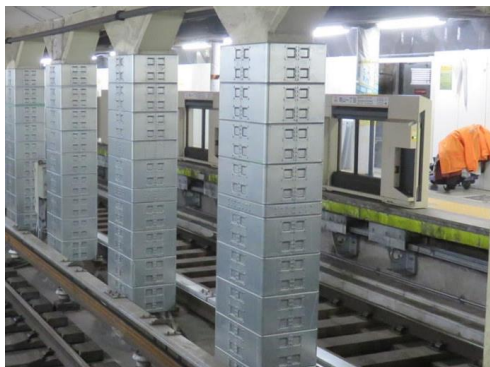
トンネル中柱補強
