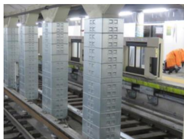
トンネル中柱補強
