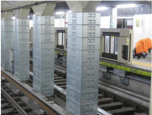
トンネル中柱補強
