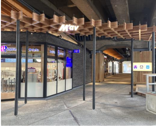
浦安駅高架下(M'av浦安)
