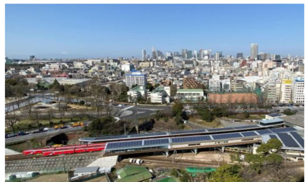
■ 丸ノ内線四ツ谷駅の太陽光パネル
