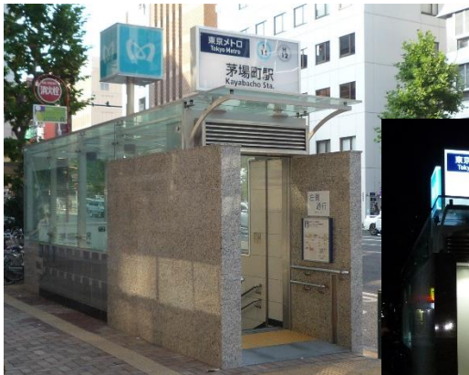
上写真：完全防水型の出入口 （東）茅場町 H26.8 供用開始 右写真：防水扉を閉扉した状態
