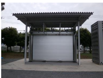
上写真：防水シャッター 右写真：折れ戸式防水扉
