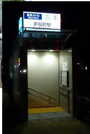
上写真：完全防水型の出入口 （東）茅場町 H26.8 供用開始 右写真：防水扉を閉扉した状態
