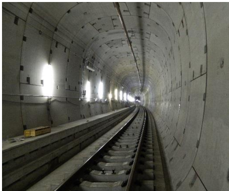
供用を開始した新木場方面の連絡線
