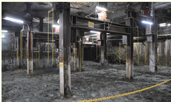
▲現在工事中の地下2階
