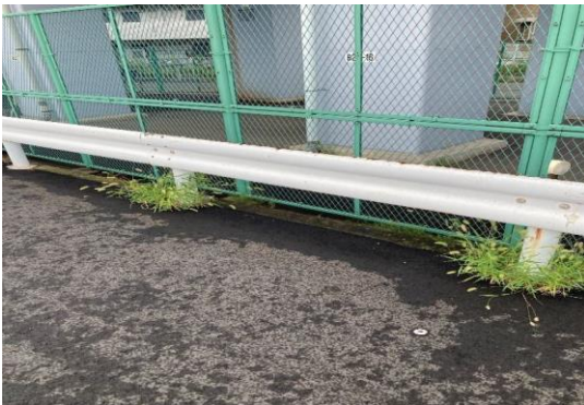
(参考2)当該車両部品が落下した場所(高架下の路上)
