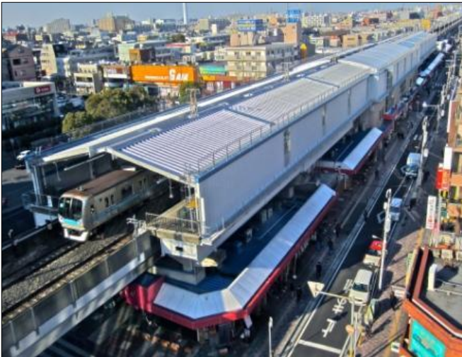
リニューアルした東西線南行徳駅の全景
