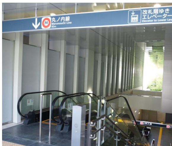
新設出入口内観
