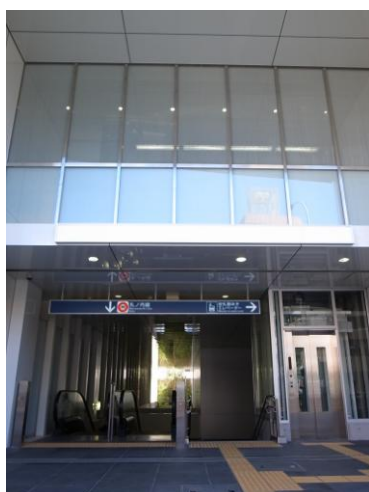
新設出入口外観
