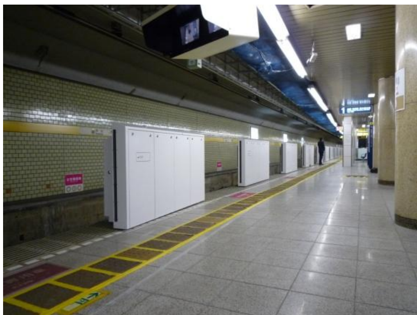
設置工事中の有楽町線千川駅のホームドア
