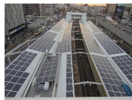
東西線西船橋駅に設置した 太陽光発電パネル
