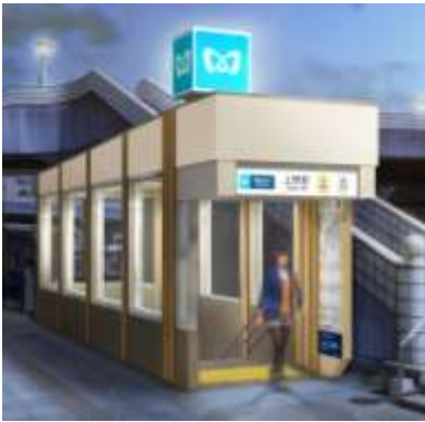
完全防水型出入口
