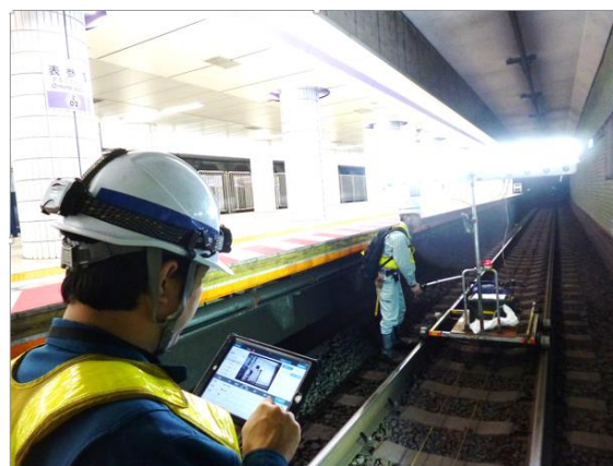
土木構築物検査の様子
